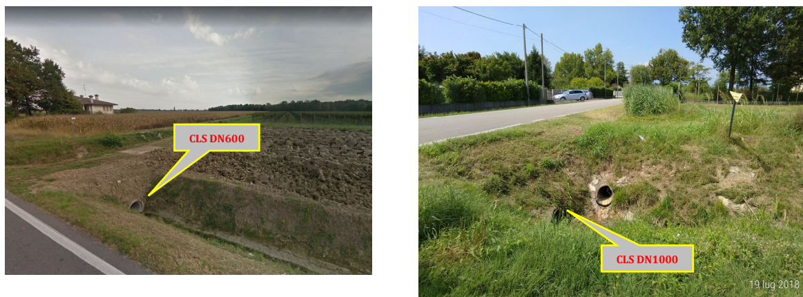
Fig. 2.5 Tombinamenti lato campagna (sinistra) e in attraversamento a Via Risorgimento (destra)
