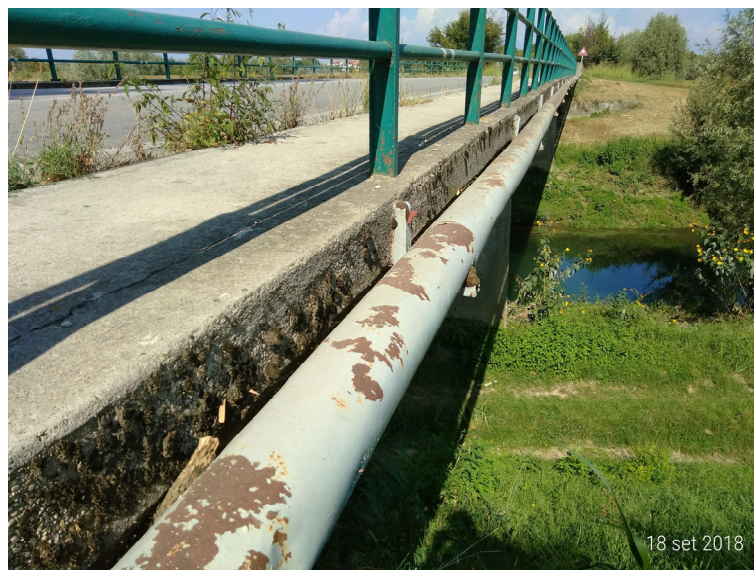
Fig. 2.3 Attraversamento aere su Ponte Monticano: veduta verso nord della condotta esistente in acciaio DN100 mm
